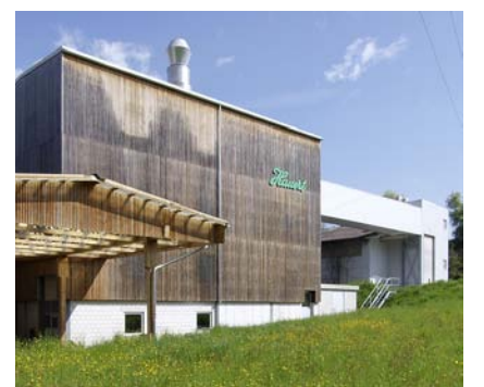
Der modernste Teil der heutigen Fabrikationsgebäude.
